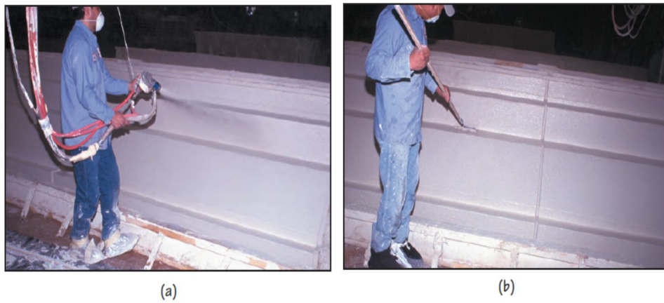
شکل ۶-۴۱-الف) پاشیدن مخلوط GFRG بر روی لایه آستر. (ب) متراکم کردن مخلوط با استفاده از روش غلتک‌زنی در لبه‌ها و گوشه‌های قالب
