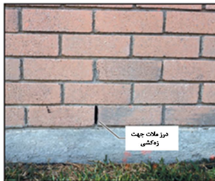
شکل ۵-۱۵- خالی گذاشتن درز ملات جهت زه‌کشی
