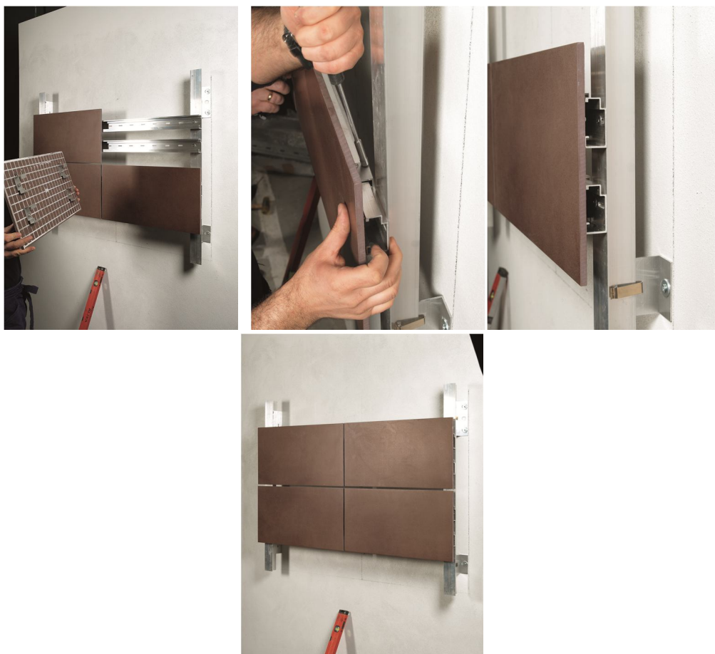
شکل ۷-۳۱ - مراحل نصب سیستم نصب پنهان
