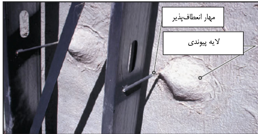
شکل ۶-۳۸ - لایه پیوندی و مهارهای انعطاف‌پذیر
