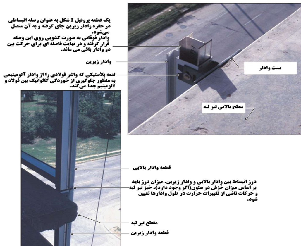
شکل ۸-۸- نمونه اتصال انبساطی بین دو قطعه وادار
