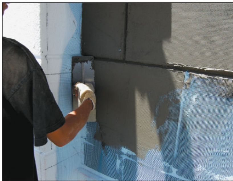
شکل ۶-۱۸- اجرای لایه‌های پوششی
