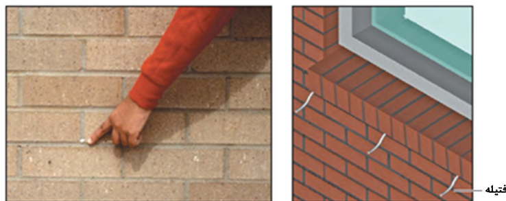
شکل ۵-۱۷- فتیله‌های از جنس کتان جهت حفره‌های زه‌کشی
