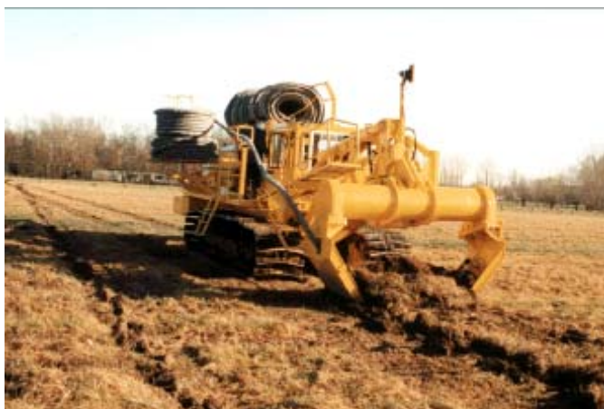
شکل شماره ۵-۷-۳- یک ترنچر ذوزنقه ای در حال حفاری
