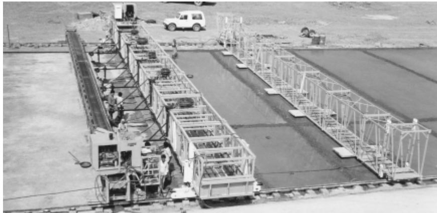
شکل ۴-۱۶-۳- استفاده از یک فینیشر در کنار تجهیزات پخش و پرداخت سطح بتن
