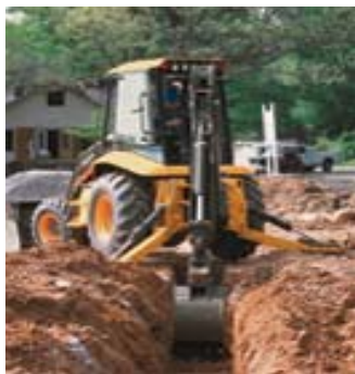
شکل شماره ۹-۲-۲- حفر کانال توسط بکهولودر
