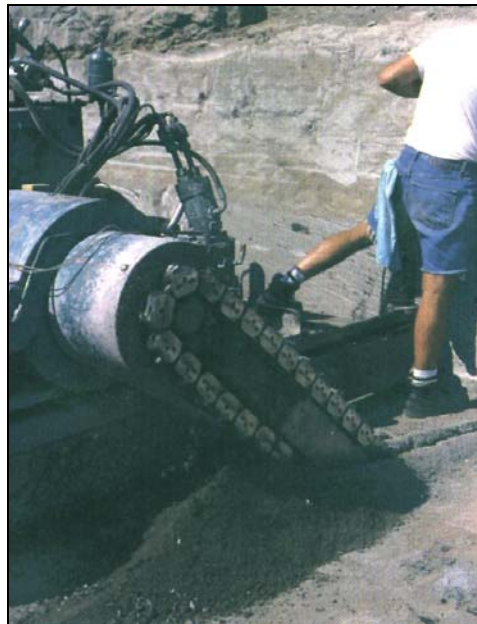
شکل ۳-۲۷-۱۳- نمونه ماشین هاواژ که به صورت خشک کار می‌کند
