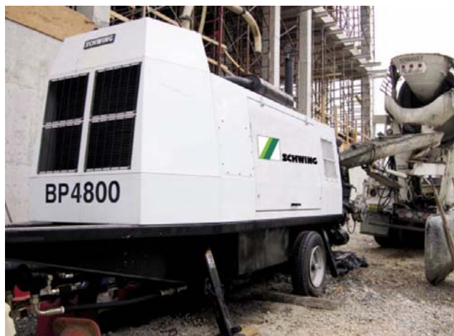
شکل ۴-۱۰-۴- پمپ بتن کارگاهی (زمینی)
