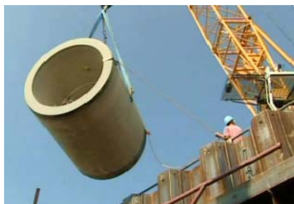
شکل ۵-۱۰-۳- هدایت لوله‌های بتنی درون شفت ارسال
