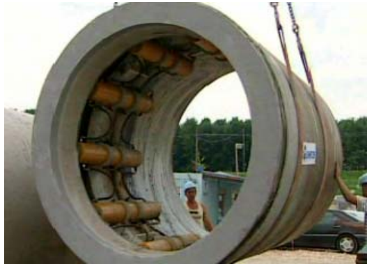
شکل ۵-۱۰-۴- لوله بتنی مخصوص عملیات لوله رانی
