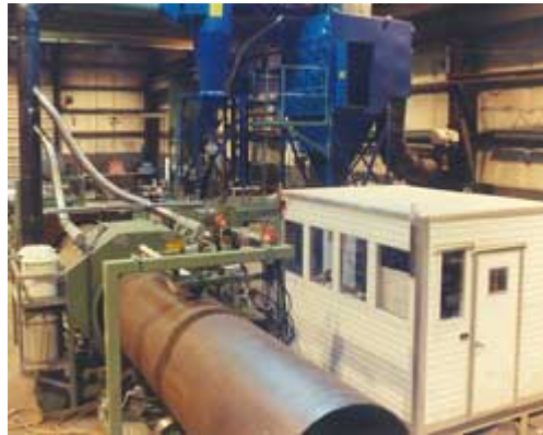
شکل ۵-۴-۷- کارگاه پوشش دهی
