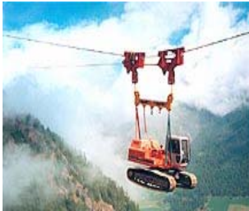
شکل ۶-۶-۱- جرثقیل کابلی در حال حمل بیل مکانیکی
