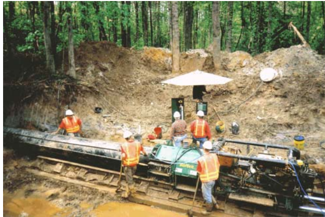
شکل ۳-۴-۷- استفاده از اوگر برای حفاری افقی
