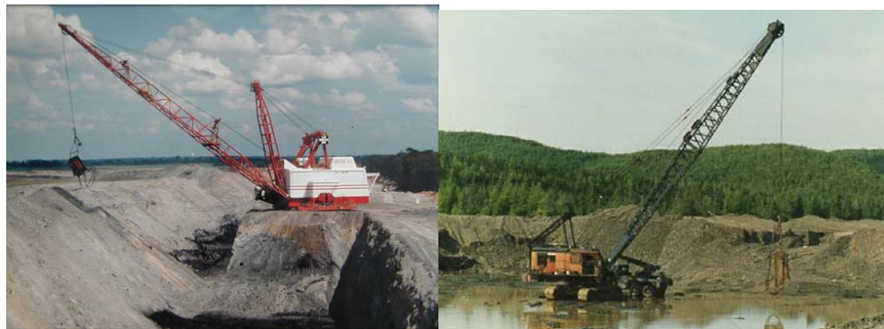
شکل شماره ۲-۱۲-۱- سمت چپ دراگلاین در حین حفاری گودال و سمت راست دراگلاین در حین حفاری زیر آب
