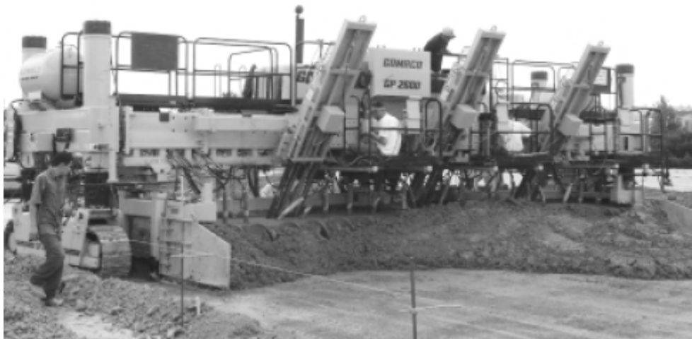
شکل ۴-۱۶-۱۲- سه بخش جاگذار آرماتور که بر روی فینیشر نصب شده‌اند
