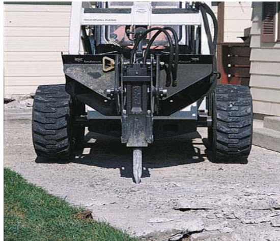
شکل ۲-۱۵-۳- چکش هیدرولیکی متصل به بابکت
