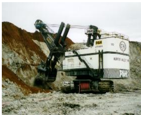
شکل ۳-۱۹-۲- شاول در حال عملیات لایه برداری
