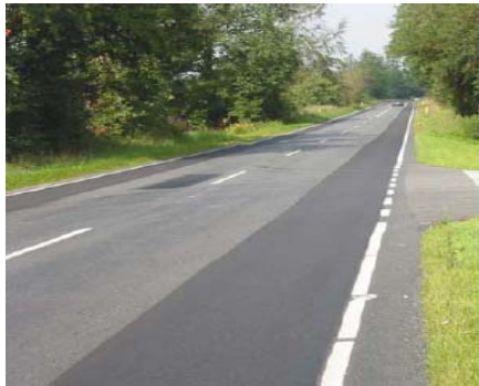
شکل شماره ۲-۲۰-۳- لکه گیری جاده ها
