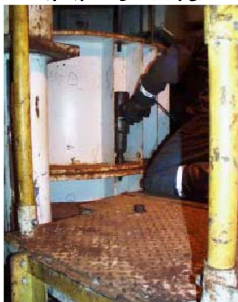
شکل ۳-۲۲-۱۵- نمایش اتصال کیسینگ‌ها به وسیله بولت
