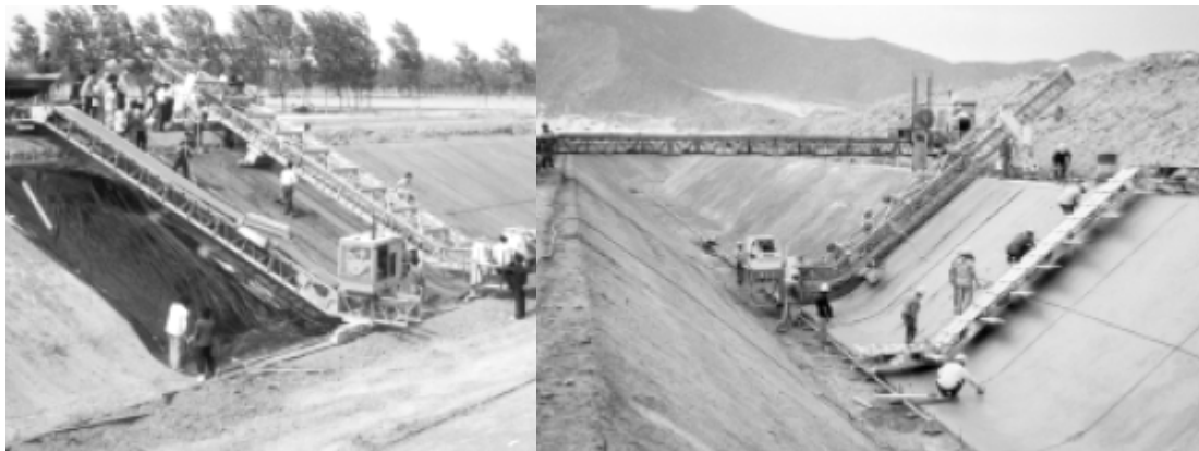
شکل ۴-۱۶-۴- استفاده از فینیشرهای سیلندری برای اجرای رویه بتنی کانال در کنار تجهیزاتی برای انتقال بتن و شیارزنی
