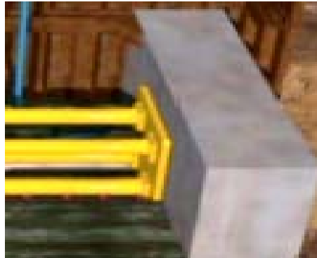
شکل ۵-۱۰-۷- دیوار فشاری پشت دستگاه (THRUST WALL)
