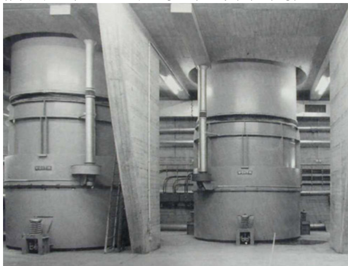
شکل ۶-۱۴-۹- بادبزن محوری قائم در تونل Elbe آلمان
