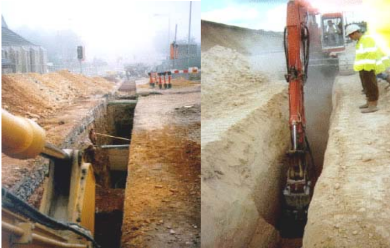
شکل ۳-۵-۳- کاربرد باکت حفار در حفر ترانشه
