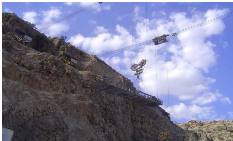
شکل شماره ۶-۶-۱۰- سیستم شاریوت جرثقیل کابلی
