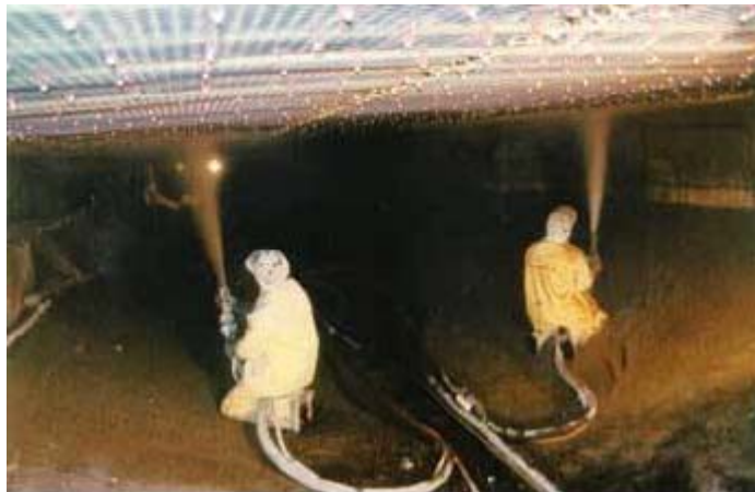
شکل ۴-۱۸-۱- نمایشی از کاربرد شاتکریت
