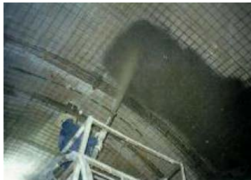
شکل ۴-۱۸-۲- استفاده از شاتکریت برای نگهداری فضاهای زیرزمینی
