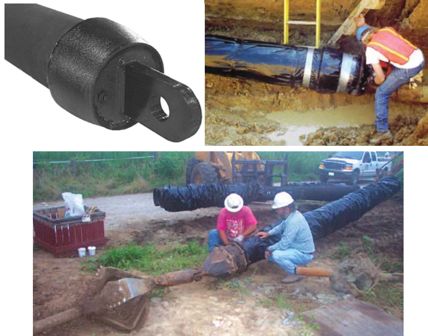
شکل ۳-۲۹-۷- نصب لوله به راد
