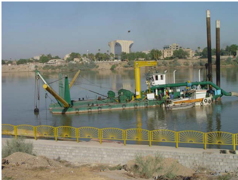
شکل ۵-۸-۱- لایروب در سطح رود کارون (منطقه اهواز)
