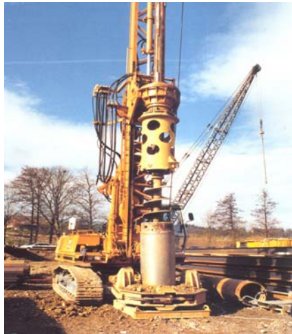
شکل ۳-۴-۶- استفاده از اوگر برای حفاری قایم
