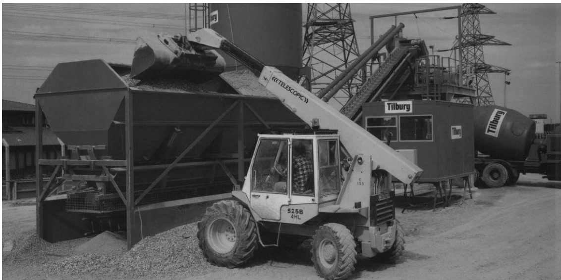
شکل ۴-۱-۴- لودر در حال انتقال سنگدانه به مخزن بچینگ
