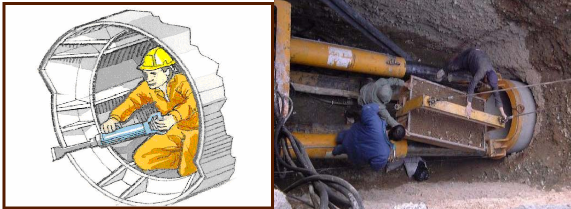
شکل ۵-۱۰-۵-الف: خروج مصالح حاصل از حفاری به شیوه دستی با باکت چرخ لاستیکی ب:دستی حفاری به روش دستی
