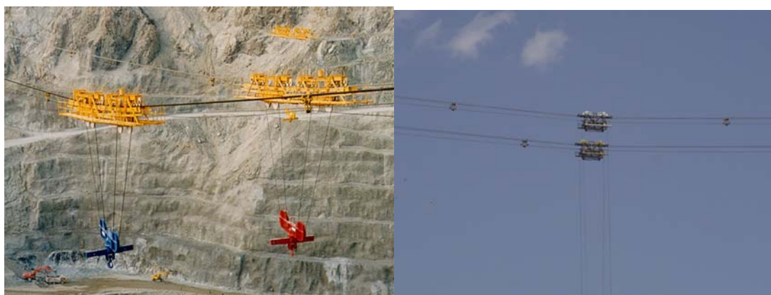
شکل ۶-۶-۹- سیم بکسل‌های جرثقیل کابلی
