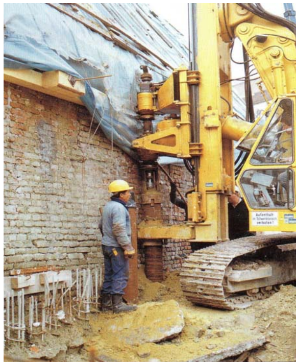
شکل ۳-۴-۱۰- حفاری با اوگر در مجاورت دیوار
