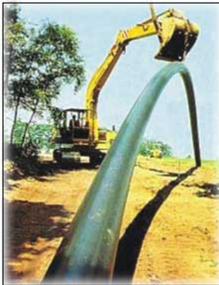
شکل ۵-۹-۲- نمونه کاربرد لوله پلی اتیلن در آبرسانی
