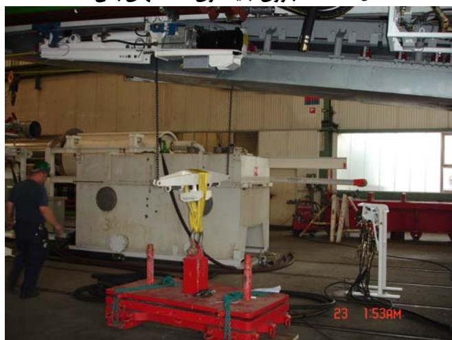
شکل ۳-۳-۲۴. جرثقیل ۲۰ تن حمل سگمنت بتنی
