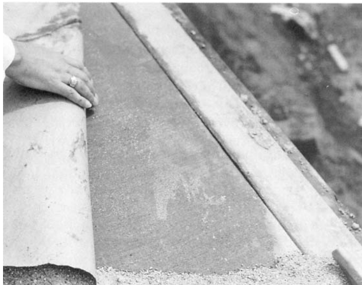
شکل ۳ عمل آوری عایقی (پوشش‌های مرکب)
