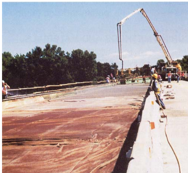
شکل ۱ عمل‌آوری با پارچه چتایی و خیس کردن متوالی آن
