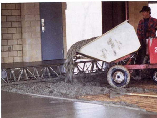
شکل ۳ روش صحیح ریختن بتن
