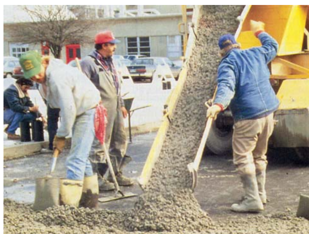
شکل ۴ انتقال بتن با استفاده از سطح شیب‌دار
