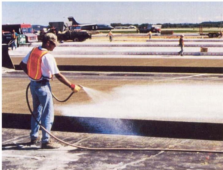
شکل ۴ روش عمل‌آوری با ماده شیمیایی غشایی
