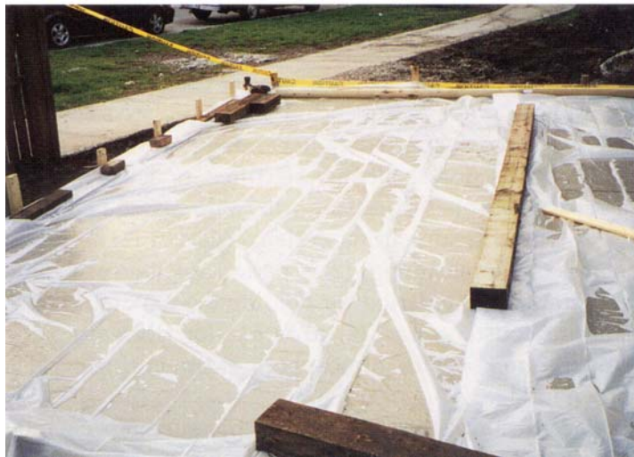
شکل ۲ عمل آوری با پلاستیک
