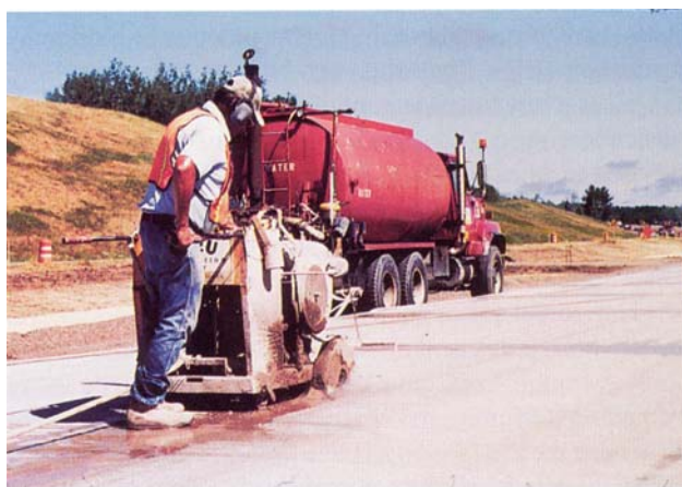
شکل ۱ استفاده از دستگاه برش برای ایجاد درز
